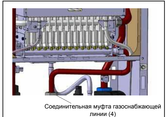
Рис.: Очистка газовой горелки
